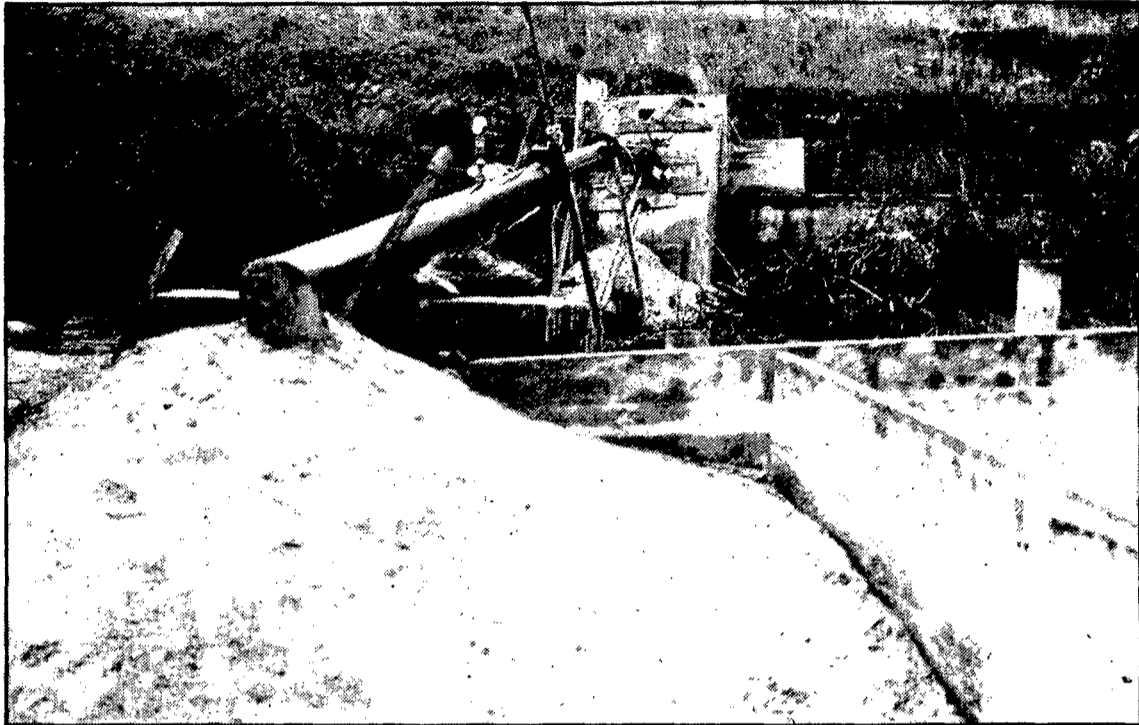
Les canonades de Figueres varen quedar molt malmeses amb l'obertura de les comportes del pantà de Boadella. (Foto PUÉRTOLAS).
